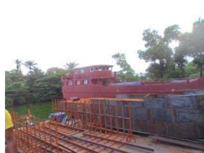
Figure 16 : Chantier naval au port fluvial de Manangareza à Toamasina
