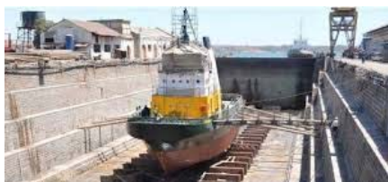
Figure 15 : Bassin de radoub de SECREN
